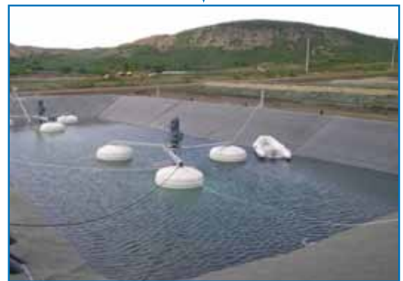
TECHNIP renouvelle sa commande pour la base vie de Koniambo en Nouvelle Calédonie. La station d'épuration sera doublée.
